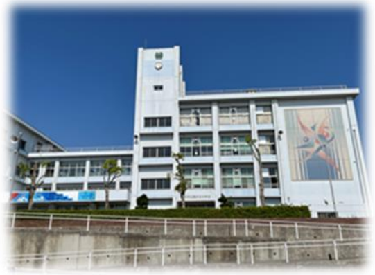
蒼天のもと、グラウンドから見る校舎
